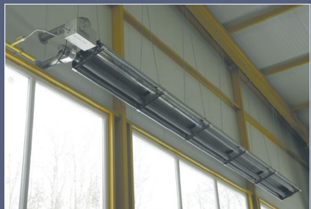
Installation des Dunkelstrahlers
