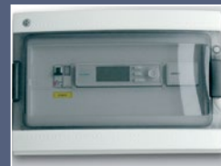
Schaltschrank Siemens Climatix
