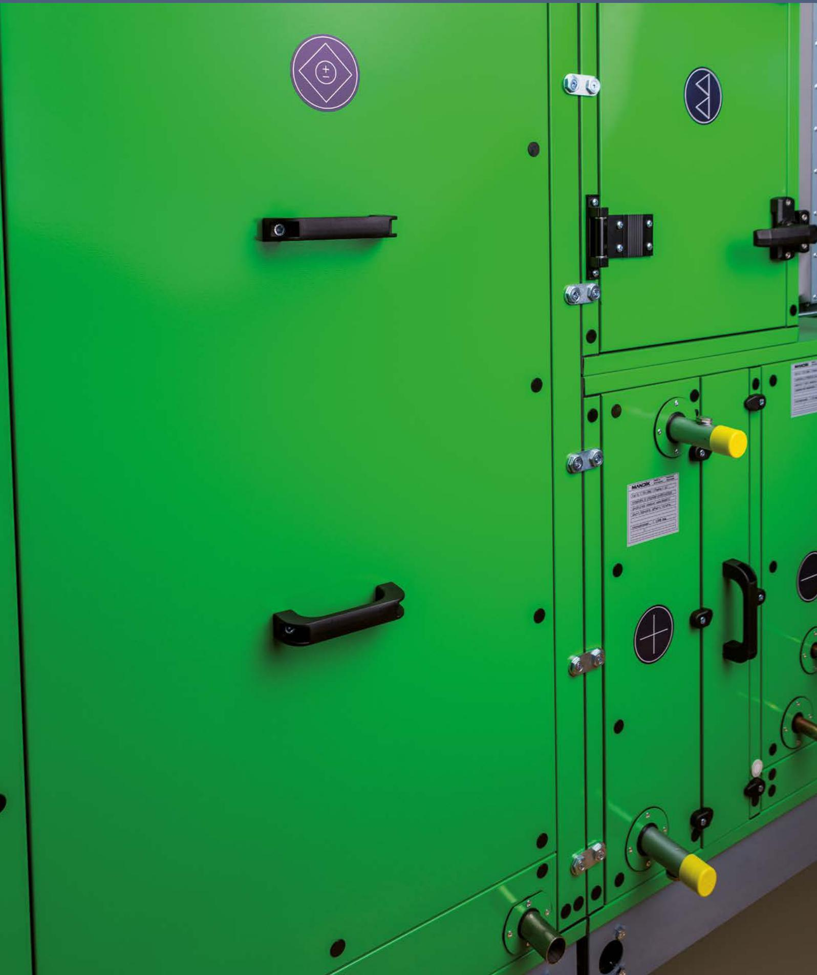
» M4 Передняя сторона- выходы теплообменников, камера фильтрация
