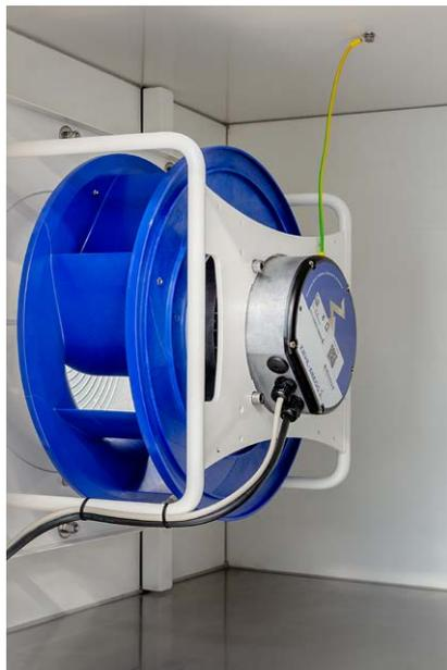
La circulation de l'air est assurée par une roue libre aux ailettes recourbées vers l'arrière, qui est entraînée par des électromoteurs EC/AC.
