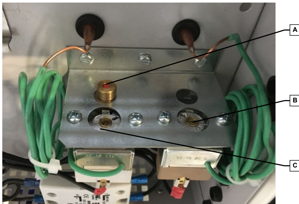
Obr 18 Popis elektroohřevu jednotky CPV.
