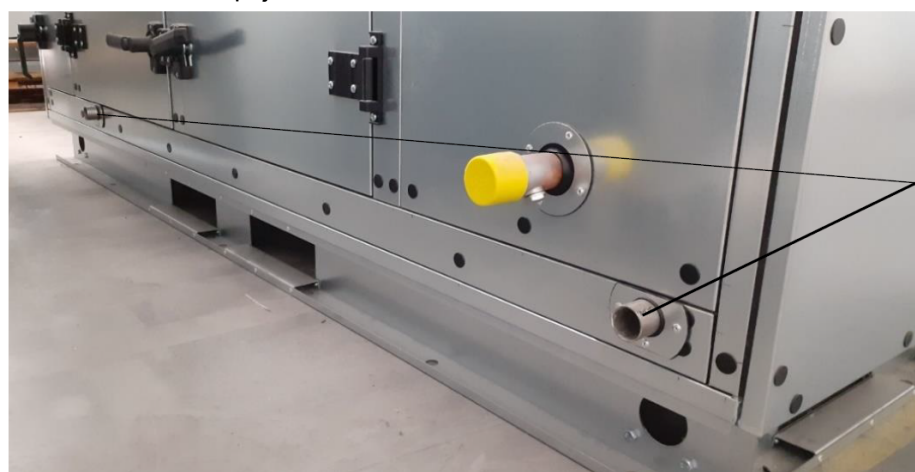
Obr.: Místo napojení sifonu
